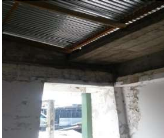
Foto No. 20140625_102046 Cubierta de tercera planta
